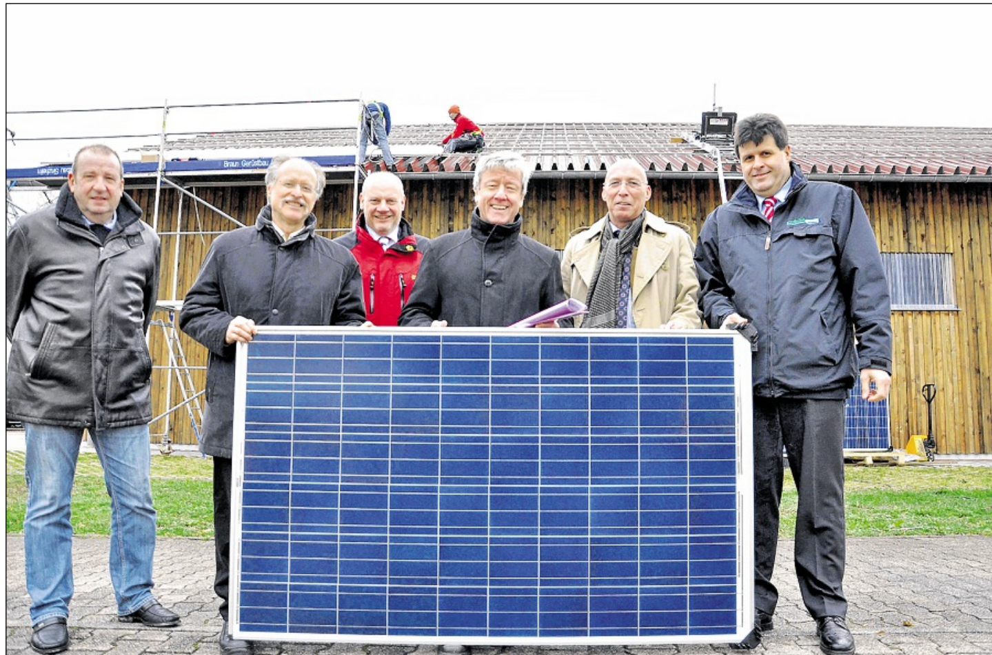
EINE FOTOVOLTAIK-ANLAGE nimmt die Bühler BürgerEnergiegenossenschaft auf dem Dach der Balzhofener Lagerhalle in Betrieb. Im Bild von links: Thilo Trautmann, Karl Ehinger, Rüdiger Höche, Hans Striebel, René Nieland und Reiner Liebich. Foto: Margull
